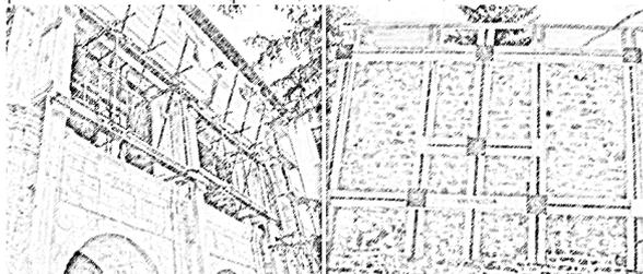
Fig. 1.7 Esempio di tirantatura eseguita su un edificio e su una parete in ribaltamento
