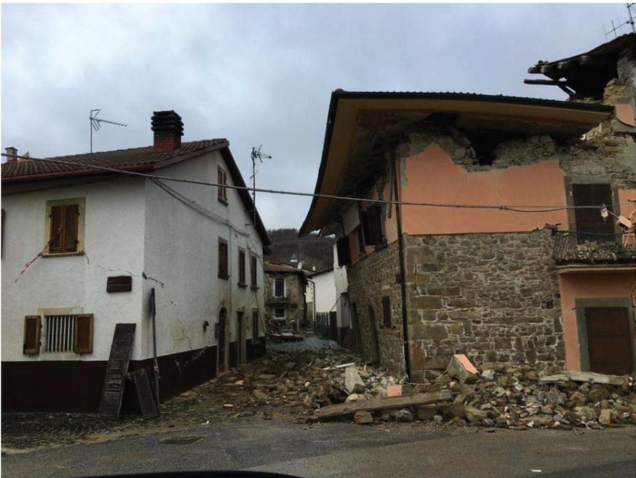
**Figura 1.1.** Danneggiamenti causati dall'inserimento di elementi di copertura pesanti su murature in pietra.
