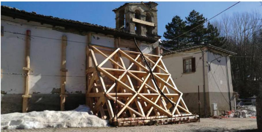
**Figura 2.2.** Introduzione di presidi provvisori per scongiurare l’evolversi di meccanismi di ribaltamento fuori dal piano di pareti in muratura.
