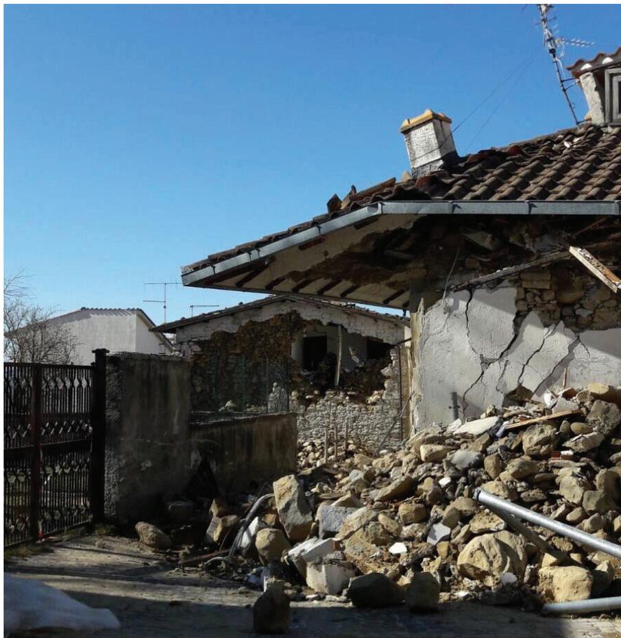
**Figura 1.2.** Danneggiamenti causati dall'inserimento di elementi di copertura pesanti su murature in pietra.
