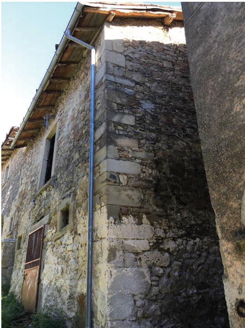
**Figura 2.1.** Dettaglio di un edificio storico in muratura mista e irregolare: l'angolata presenta pietre di maggiori dimensioni rispetto alla pezzatura media utilizzata nei paramenti e una disposizione più regolare.
