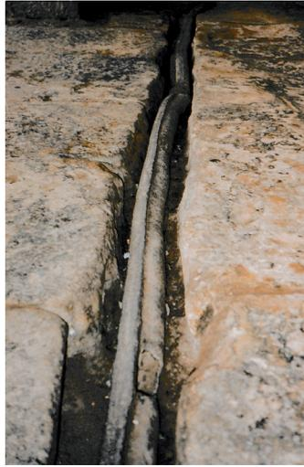
**Figura 2.** Bath. Terme romane del I° sec. d.C. Tubo in Pb per la distribuzione dell'acqua.
