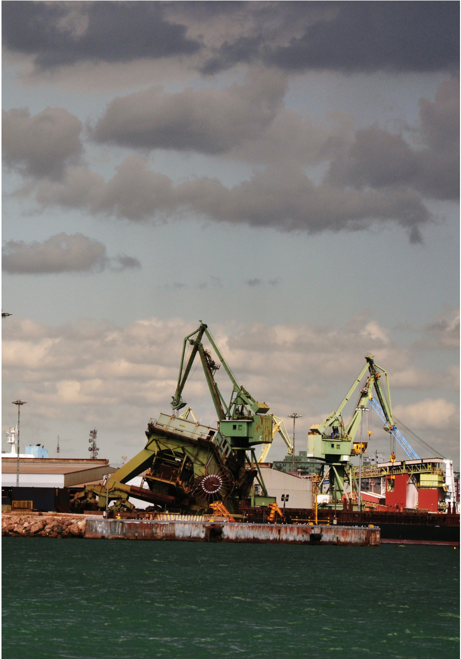
Figura 0.1. La gru del porto di Taranto crollata durante la tromba d'aria del 2014.
