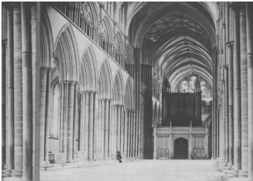
Fig. 1.2. L'interno della Salisbury Cathedral verso est. Si noti il fondale sostituito dal Wyatt che fu nuovamente rimosso e sostituito da Sir G.G. Scott con un nuovo screen in metallo lavorato. Fonte: G. STAMP, Gothic for the Steam Age: An Illustrated Biography of George Gilbert Scott , 2015, p.197.
