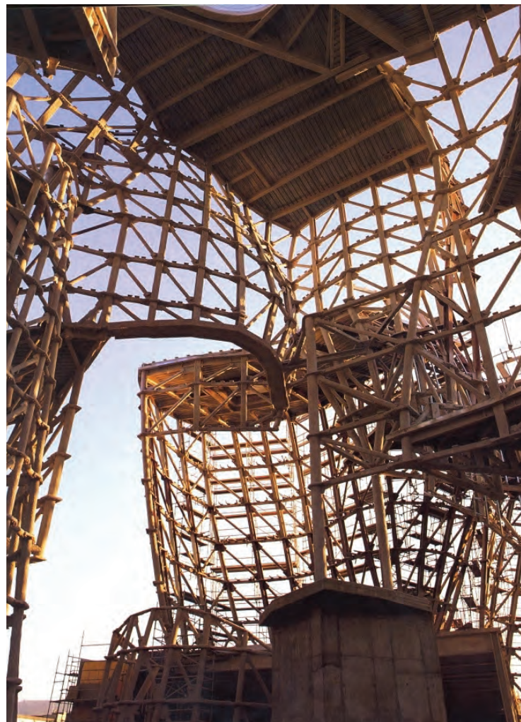
Figura 1.11. Guggenheim Museum, Bilbao. Fasi esecutive dello scheletro portante.
